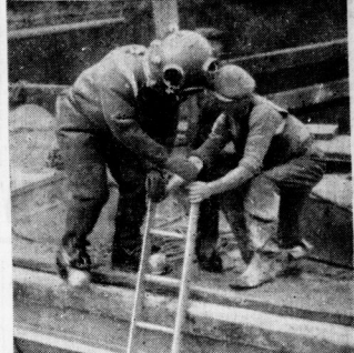
Der Leiter der Materialprüfstelle steigt zum Saalegrund hinab, um die Dükerleitung zu kontrollieren
