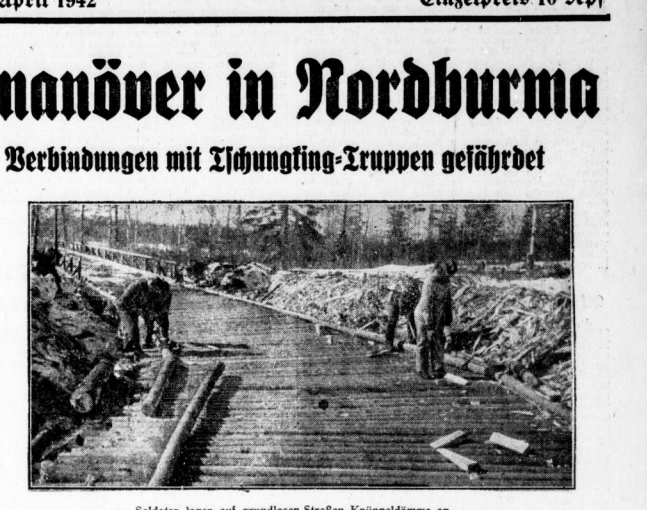
Soldaten legen auf grandiosen Straßen Knüppeldämme an. Mit Beginn des nun eingetretenen Tauwetters im Osten setzt überall die Vorbereitungen für die Instandsetzung der Nachschubwege ein. Hier werden auf besonders lehmigen Straßen, auf denen alle Fahrzeuge versinken, neue Knüppeldämme angelegt, damit ein reibungsloser Nachschub für leichte und schwere Fahrzeuge durchgeföhrt werden kann. (PK-Kriegsberichtern Rmas (Sch.)
