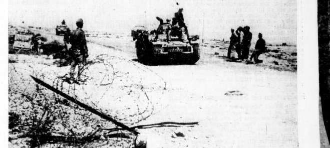
Auf der großen Küstenstraße in Nordafrika Deutsche Panzer auf der Via Balbia, der wichtigsten Verbindungsstraße an der Nordafrikaküste. An der Fortsetzung dieser Straße entlang sind die deutschen und italienischen Truppen tief nach Ägypten eingedrungen und haben am Montagvormittag die Festung Marja Matruf erobert. (PK-Aufnahme Kriegsberichterstatter Valtinogov (Sch.))
