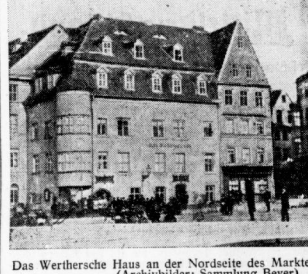
Das Werthersche Haus an der Nordseite des Marktes (Archivbild; Sammlung Beyer)
