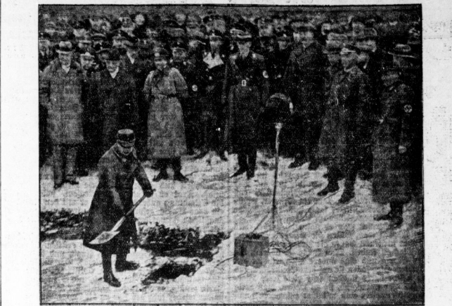
In Anwesenheit des Generalinspektors der Reichsautobahnen, Dr. Todt, wurden die Bauarbeiten an der Reichsautobahn Königsberg-Elbing feierlich eröffnet. Auf unserem Bild führt der Oberpräsident von Ostpreußen, Gaultier Koch, den ersten Spatenstich.
