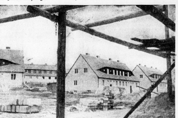
Gaßh-Siedlungshäuser an der Mätzlicher Straße. (Aufnahme: H. Ziegler)
