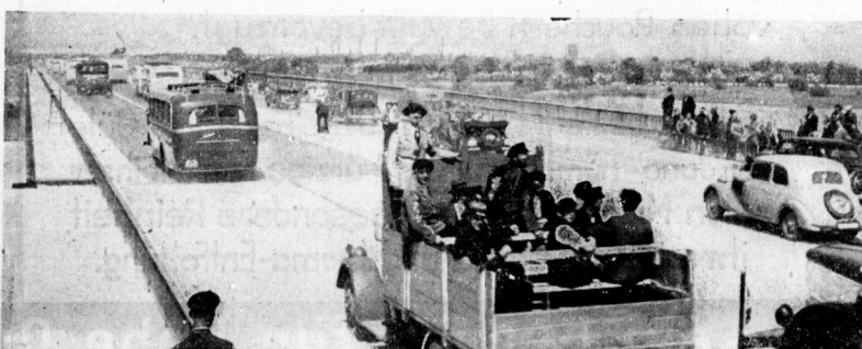
Die neue Autobahnbrücke bei Hamburg
