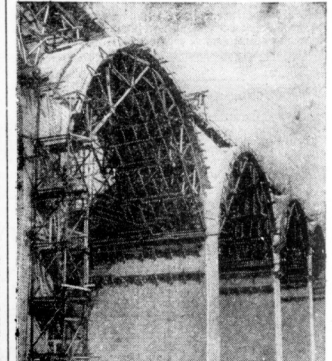
Im Baubereich der Reichsautobahn Köln-Frankfurt geht auch die große Bauwerk der Wiedtal-Brücke...
