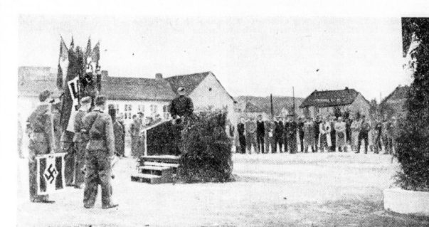
Das Jahrestreffen der mitteleuropäischen Bauindustrie, über das wir im Wirtschaftsteil dieser Zeitung ausführlich berichteten, fand gestern seinen Auftakt mit einer Morgenfeier in der Lehrbaustelle. (Aufnahme: Giegold-Schilling)
