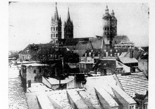
Blick auf den Naumburger Dom, an dem zur Zeit größere Arbeiten vorgenommen werden; rechts am Osletiner ist das Baugerüst sichtbar.
