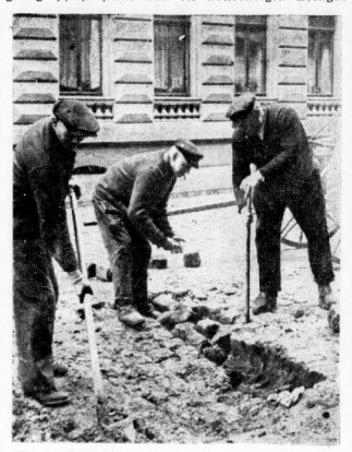
Eine Arbeitsstelle in der Lessingstraße, an der das Pflaster gehoben wird. (Aunf. Giegold-Schilling)
