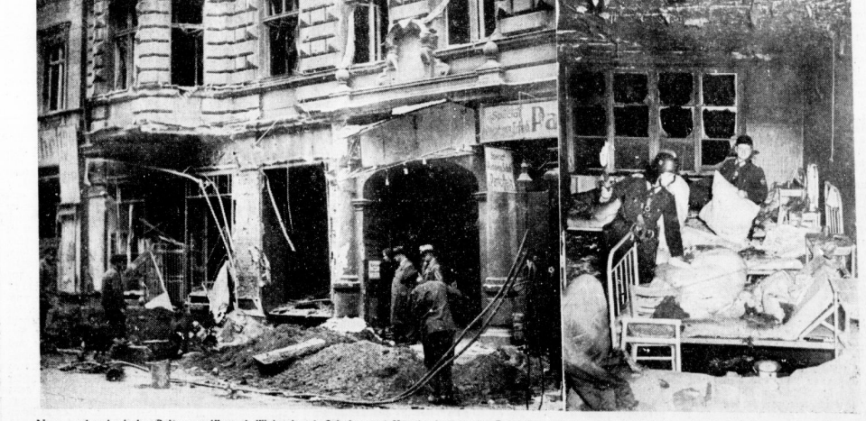
Neue verbrecherische Britenangriffe auf Wohnviertel, Schulen und Krankenhäuser der Reichshauptstadt. Das Bild links zeigt Verwüstungen einer Sprengbombe in Wohnhäusern; rechts Feuerwehrleute bei den Aufräumarbeiten in einem Altersheim.
