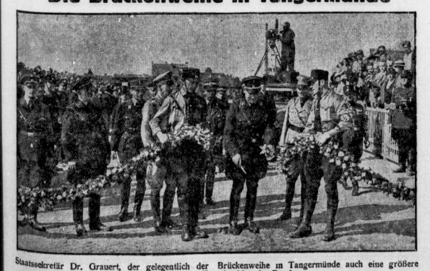
Staatssekretär Dr. Grauert, der gelegentlich der Brückenweihung in Tangermünde auch eine größere Rede hielt, beim Zerschneiden des Bandes
