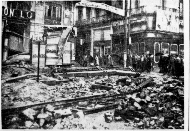
Unser Bild zeigt die Bombenwirkung an den Häusern des Anton-Martin-Platzes, der im Kampfgebiet von Madrid liegt. (Pressefoto)
