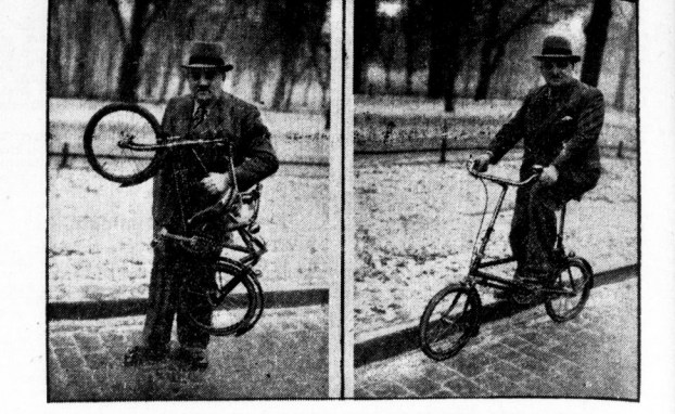
Der Berliner Ingenieur Zschka hat ein Fahrrad konstruiert, das nur kleine Räder besitzt, bequem zusammengeklappt nur wenig Raum beansprucht, trotzdem aber gut läuft. (Pressefoto, M.)
