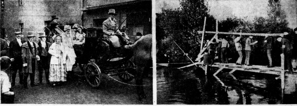
Links: Der Reisewagen Goethes während der Durchfahrt durch Halle; neben dem Wagen eine hallische Abordnung in Biedermeiertracht. — Rechts: Die Technische Hochschule Ammendort schlug gestern abend neben der Schafbrücke eine Notbrücke über die Elster. Unser Bild zeigt das Einsetzen des Mittelstücks. Den Bericht über die Durchfahrt des Goethewagens siehe Seite 6.
