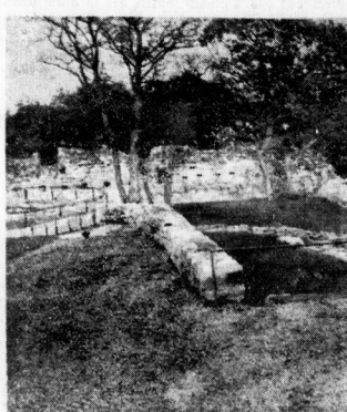
Die freigelegten Reste der gewaltigen Burganlage. Überall hat man den alten Baumbestand stehengelassen...
