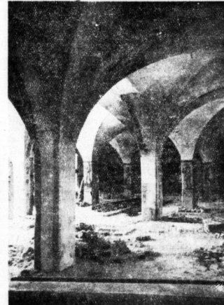
Blick in das Kreuzgewölbe des alten Kuhstalles
