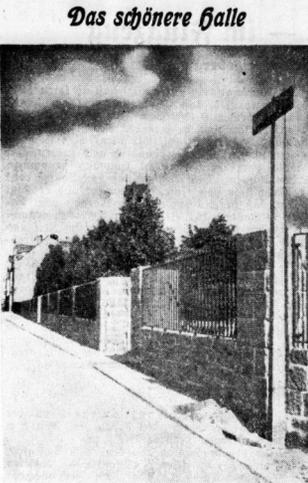
Im Zuge der Lauchstädter Straße ist die unschöne Bretterwand gefallen und dafür auf einem massiven Werksteinsockel ein gediegenes eisernes Gitter errichtet worden; eine noble Arbeit, die das Bild des ganzen Straßenzuges hebt.
