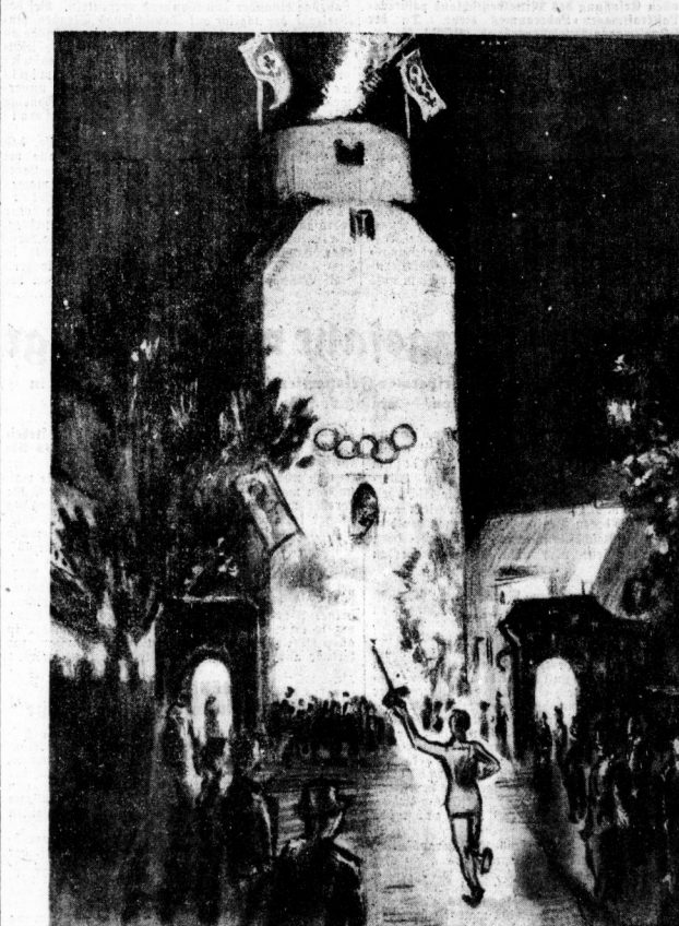
Der Fackelträger erreicht den Lubwarturm.
