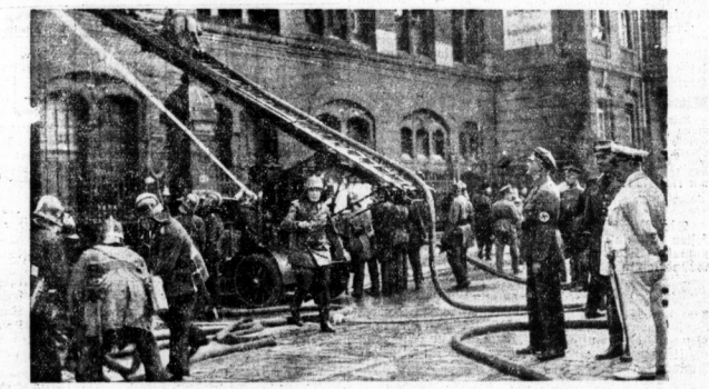
In dem Werkstätten- und Requisitehaus der Preussischen Staatstheater in Berlin brach ein Großfeuer aus, dessen Löschung die Wehren der Reichshauptstadt stundenlang beschäftigte.
