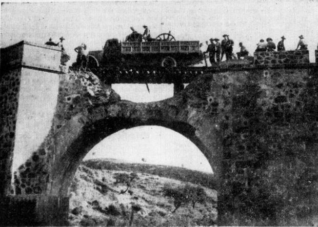
Eine von den Roten auf ihrem Rückzug gesprengte Brücke, die von nationalen Ingenieuren und Pionieren wiederhergestellt wurde. Unser Bild zeigt, wie diese Brücke auf ihre Widerstandsfähigkeit geprüft wird. (Presse-Bild-Zentrale)
