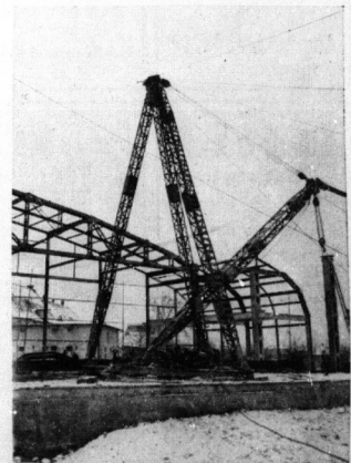
Eine der Hallen im Bau
