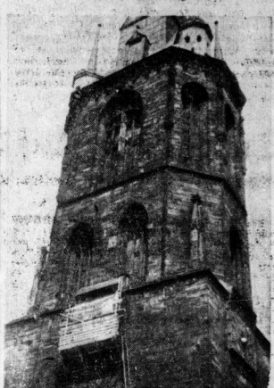
Das Arbeitspodium am Roten Turm Aufnahme: Steiner
