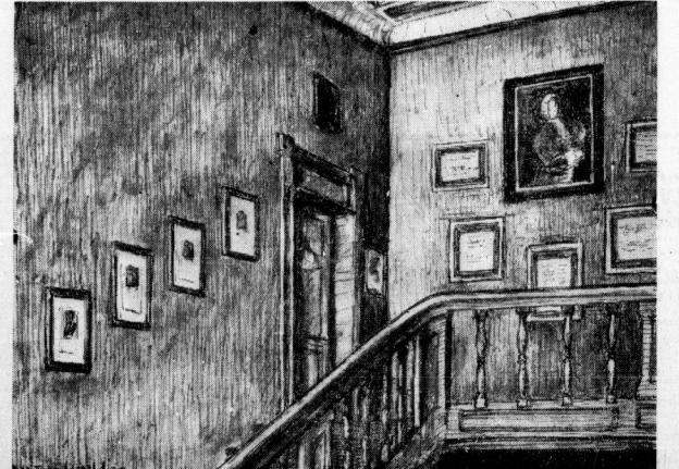
Das Treppenhaus des Akademiegebäude
