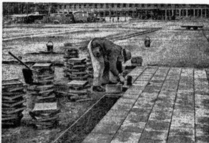
Das Rollfeld für Flugzeuge wird mit Steinplatten ausgelegt
