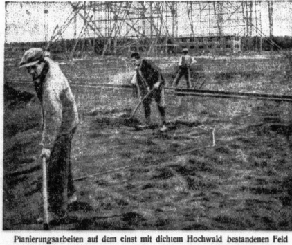
Planierungsarbeiten auf dem einst mit dichtem Hochwald bestandenen Feld
