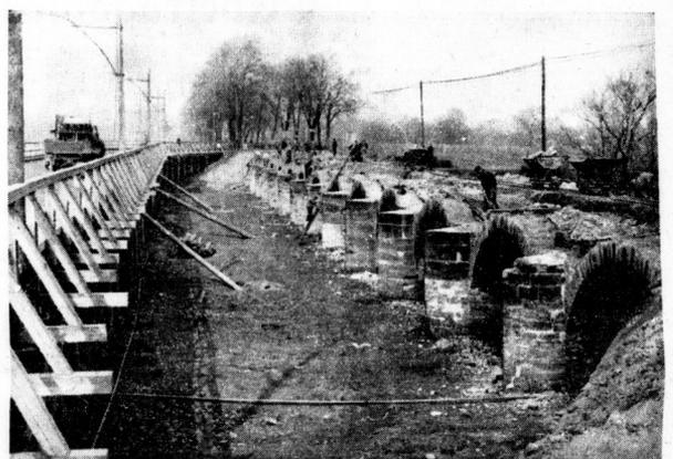
Der Abbruch der 15-Bogen-Brücke, der sogenannten Zigeunerbrücke, dicht hinter Ammendorf ist im vollen Gange. (Aut.: Schulze)
