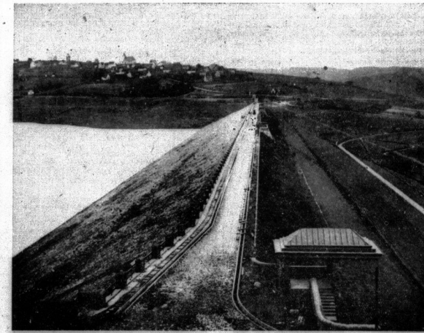
Die Sorpeltalsperre fertiggestellt. Im Kreise Arnberg im Sauerland wurde die Sorpeltalsperre mit einem Staudamm von 71 Millionen Kubikmeter fertiggestellt. Diese gewaltigen Wassermengen werden durch einen Erdkamm gestaut, der eine Höhe von 60 Meter über Talsohle und eine Sohlenbreite von 37,50 Meter hat. Die Breite der Dammkronen mit gepflasterter Fahrbahn beträgt 10 Meter. (Schubert, 8.)
