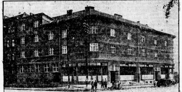
Die neue Kreisbaustelle in Diemitz.
