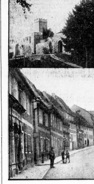
Die Eckardtstraße und Eckardtberg.
