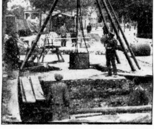
Stollmann über einem Ausbesserungsrohr.
