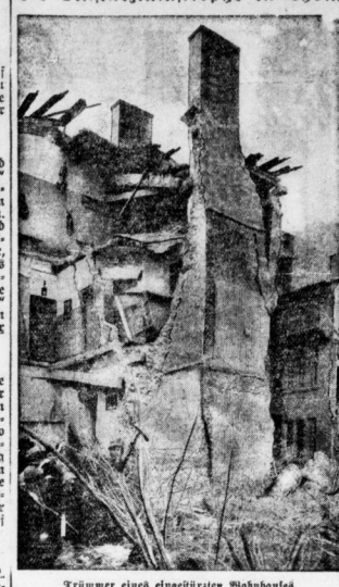
Zimmer eines eingestürzten Wohnhauses.
