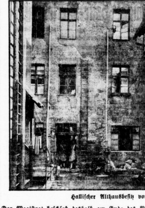
Halleischer Wohnhausbau vor und nach der Instandsetzung.
