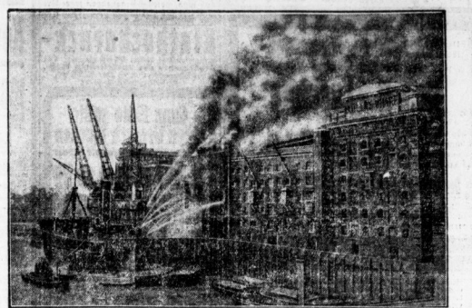
Der Brand eines schiffähnlichen Lagerhauses an der Themse gegenüber dem Tower, das mit riesigen Mengen an Holz und Kohlen gefüllt war, hat sich in der Nacht zum Sonntag in ein riesiges Feuer entzündet. Die Feuerwehr mußte mehrere Tage lang mit der Bekämpfung beschäftigt sein.
