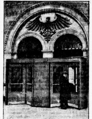
Die neue Eingangstür der Schalterhalle.
