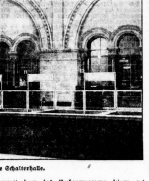
Blick in die große Schalterhalle.
