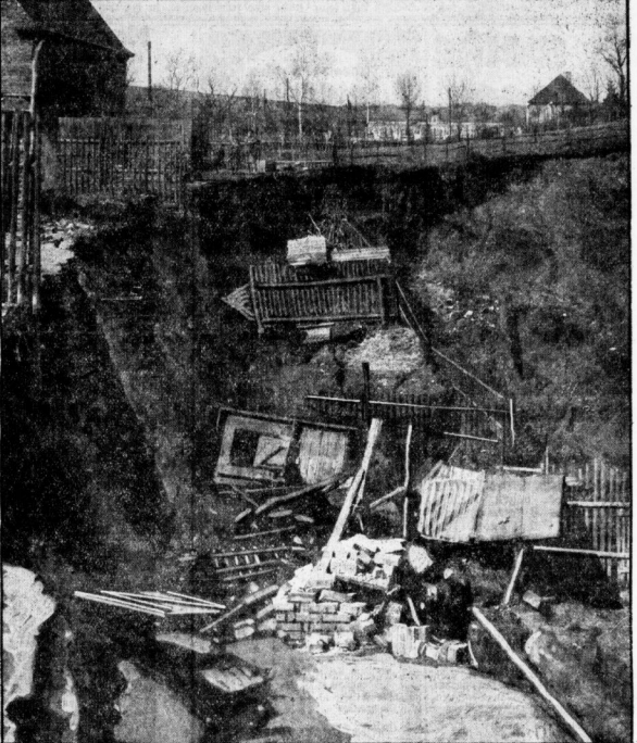
In der Querfurter Straße in Freyburg a. U. erregte sich, wie fürsich berichtet, unerwartet ein Erdsturz, der binnen Minuten so groß wurde, daß die Erdwände nachdrückten und Gebäude...
