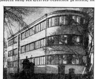
Phot. Fischer. ADR-Reubau in Halle. Architekt B. D. A. Martin Krauß.
