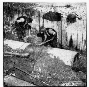
Das Klotzrohr der Kläranlage muß verlegt werden.
