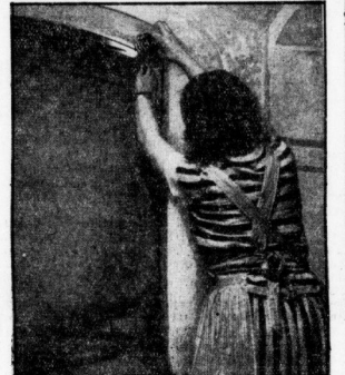
Abdichtung der Kellerkeller von innen.
