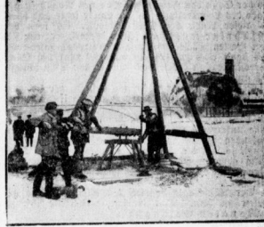
Der Bohrturm mitten auf der Saale.
