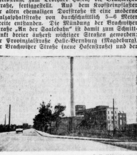
Die neue Zufahrtsstraße zum Hafen Halle-Zrotha.
