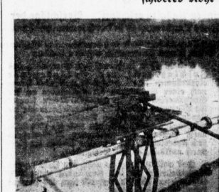
Das Wasserleitungsrohr vor der Versenkung.
