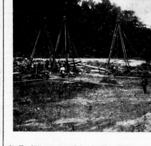
Das Bau des neuen Gebäudes ist insofern besonders interessant, weil man insofern des inneren Baugrundes...
