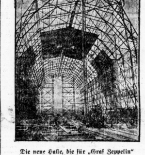
Die neue Halle, die für „Graf Zeppe“ in Friedrichshafen errichtet wurde.
