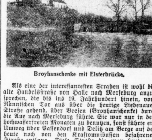
Brohnschenke mit Elsterbrücke
