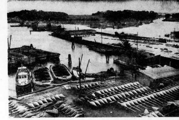
Bis jetzt wird der Eisenbahnverkehr von Stralsund nach der Insel Rügen durch eine Fähre bewerkstelligt, die ungefähr 1/2 Stunden für die Überfahrt benötigt. Dieser Fährbetrieb soll durch den Bau des Rügendamms beseitigt werden, der die Insel mit dem Festland verbinden wird. Außer der Eisenbahnlinie wird auch eine Straße über dem neuen Dammbau angelegt. In der Ferne ist die Insel Dänholm, die zunächst durch eine Brücke mit dem Festland verbunden wird. Zwischen den Spundwänden wird Sandboden für den Dammbau geschüttet. Im Vordergrund eine Reihe von Bojen, die beim Bau Verwendung finden.
