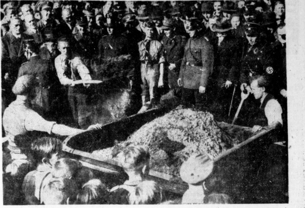
Gestern wurde mit den Arbeiten zum Ausbau der Königsstraße in Wansee begonnen, die als Ausfallstraße von Berlin nach Potsdam stark behahren wird...
