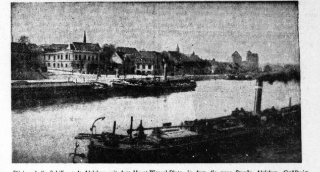
Blick auf die Schiffstraße Altleben mit dem Horst-Wessel-Platz, in dem die neue Straße Altleben-Gönlitzig (letzte Teilstrecke der Westufer-Durchgangsstraße Halle-Bernburg) einmündet wird.
