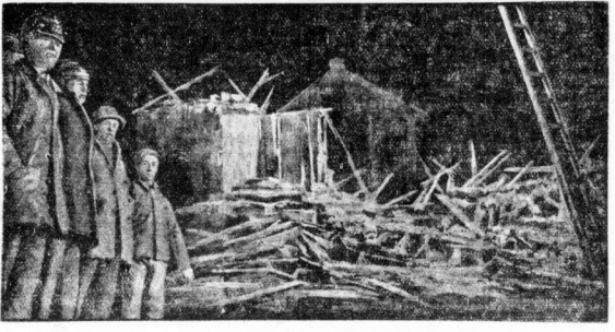
Das erste Originalbild von der einstigen Katastrophe. Eine Nachtaufnahme der Trümmer des eingestürzten Förderturms.
