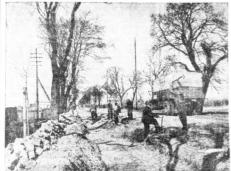
Die große Landstraße Halle-Merseburg "Weißenfels wird breiter. Die Verbreiterung wird in Bauabschnitten von etwa 200 Metern Länge durchgelterin, zwischen denen jeweils 100 Meter Fahrbahn als Ausweichstellen genz-seitig freibleiben. Innerhalb der Bauabschnitte ist die Straße der Bauabschnitte ist die Straße der fri den Verkehr halbseitig gespert. — Das Bild zeigt die Bauarbeiten vor der Stadt Merseburg in der Nähe des sogenannten "Chausseehauses".
