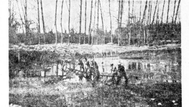
Ein Teich bei Creypau wird entschlammt
