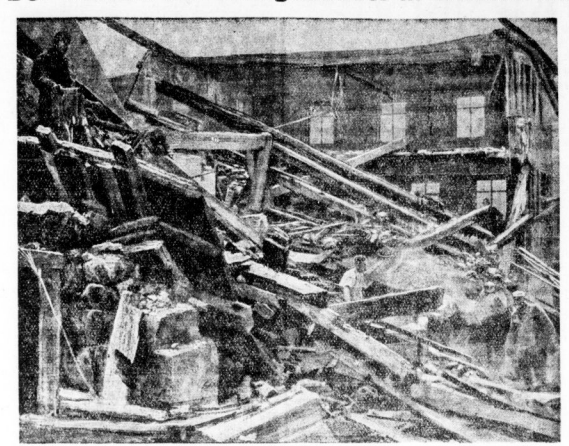
Die Bergungsarbeit an der Unglücksstätte bei Winterbach, wo ein etwa 200 Jahre altes Schulgebäude während des Unterrichts plötzlich einstürzte.
