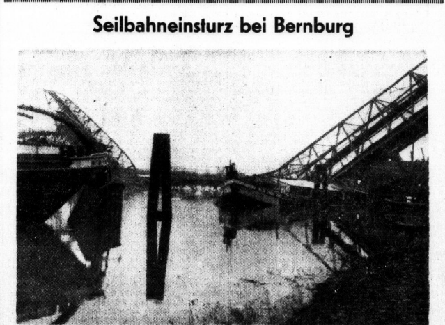
Gestern stürzte bei Bernburg in einer Länge von etwa 80 Meter eine eiserne Hängebrücke der Solway-Werke in die Saale. Der Schiffverkehr ist vollständig stillgelegt, da der Fluß in seiner ganzen Breite von dem Gestänge versperrt ist. (Aust.-Bericht Seite 7.) — Aufn.: Franz Schmidt.
