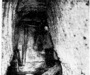
Unterirdischer Gang in Glauchau. Vorn eine drei Meter tiefe Fallgrube, mit Wasser gefüllt, hinten abgewinkelte Einsturzgefahr. Im Gang steht Wasser, das von der Decke tropft. Hinter der Fallgrube geht es recht hoch zu dem etwa 50 Meter entfernten Ausgang. Im Hintergrund ein halb eingestellener Gang.
